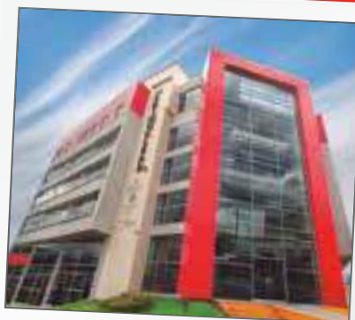
Edificio Grupo Medinuclear
